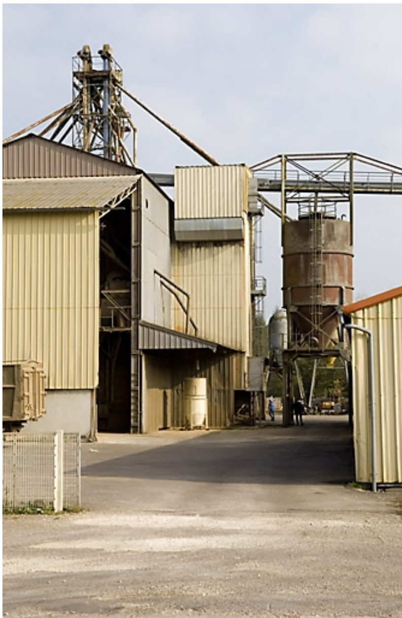
Silos et système de transport des céréales.
