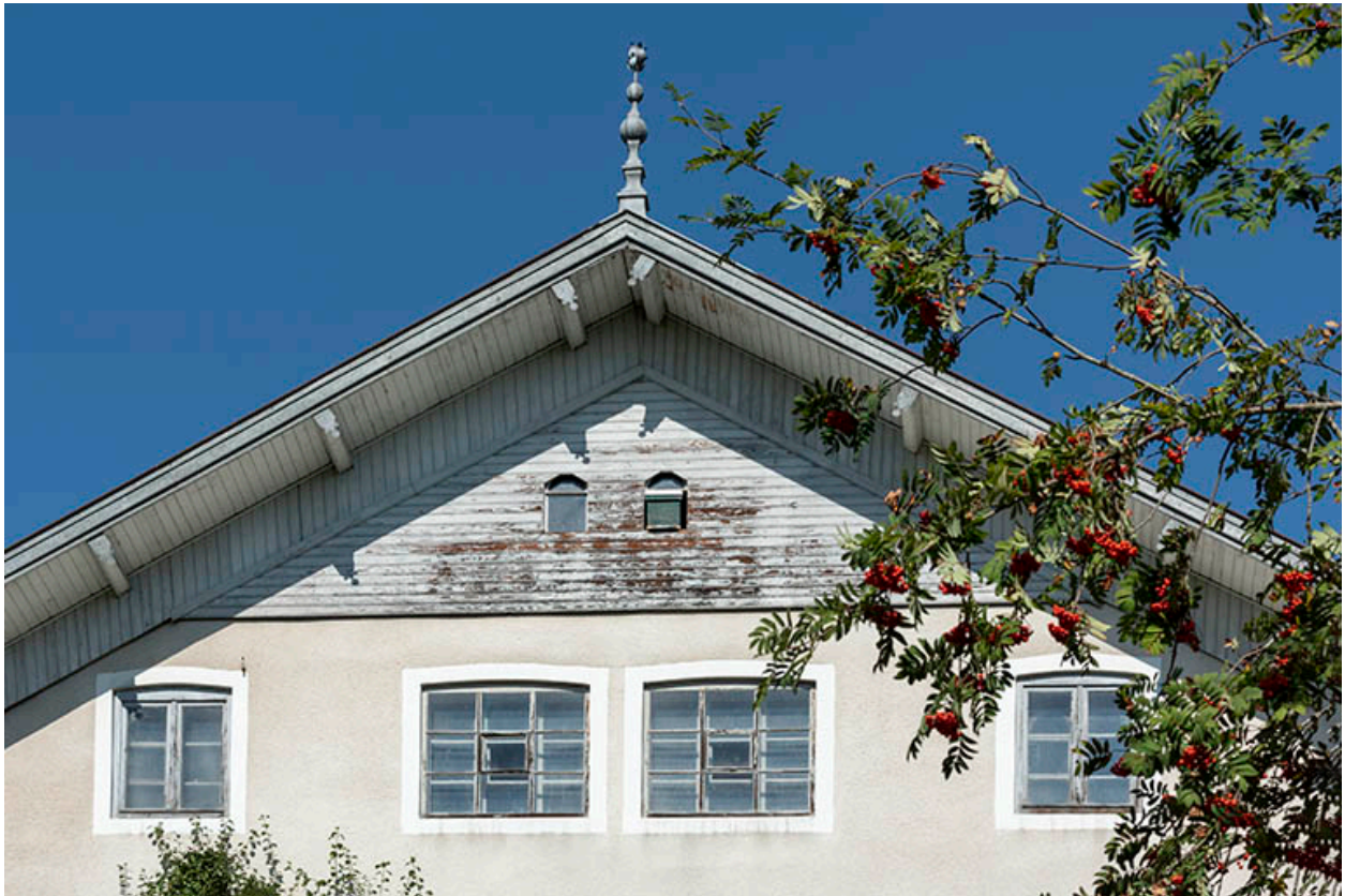
Ancienne ferme, façade latérale droite : fenêtres de l'atelier dans le comble.
