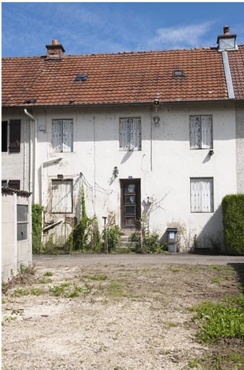
Habitation de 10 logements. Détail d'une travée.
