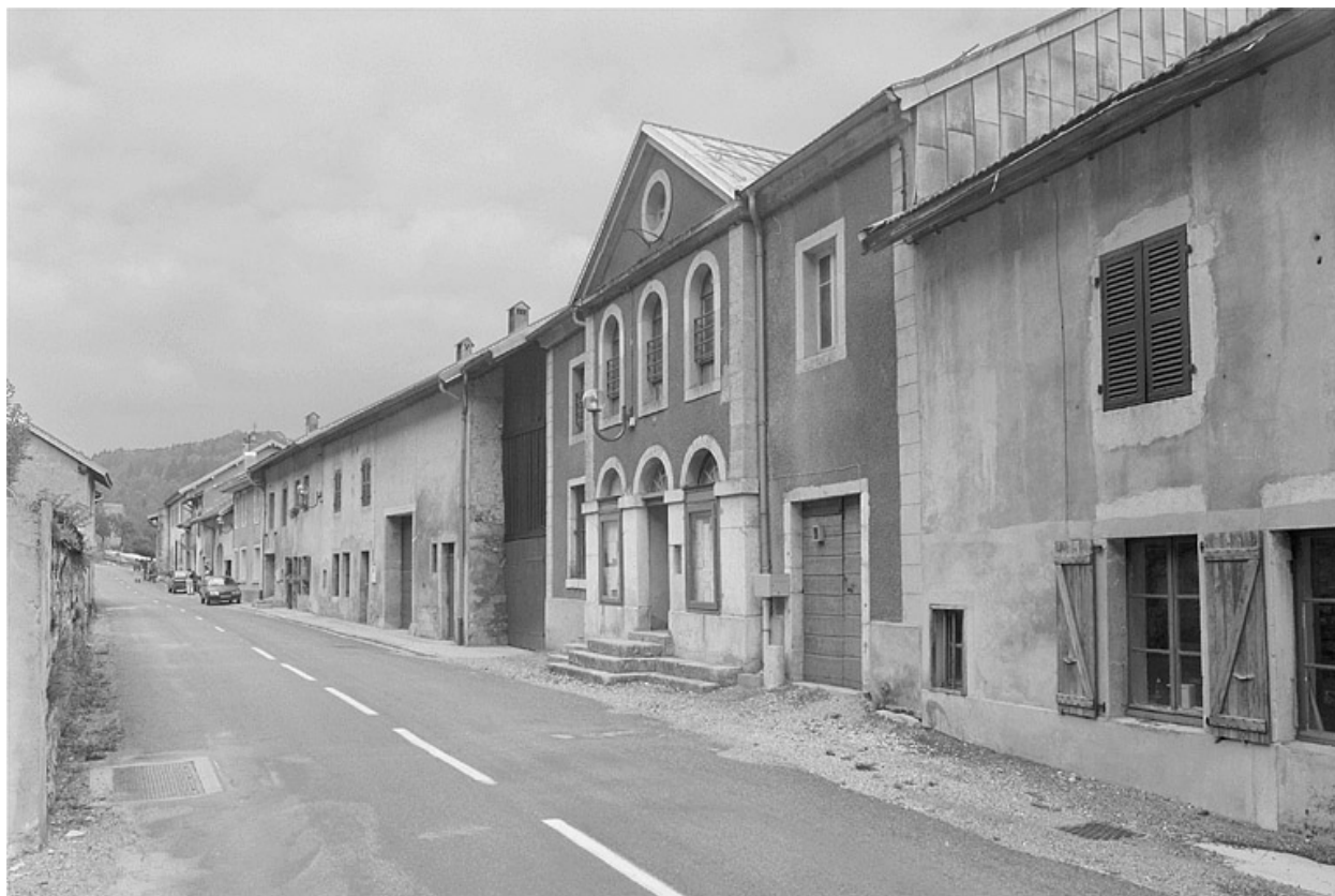
Vue depuis la rue principale.
