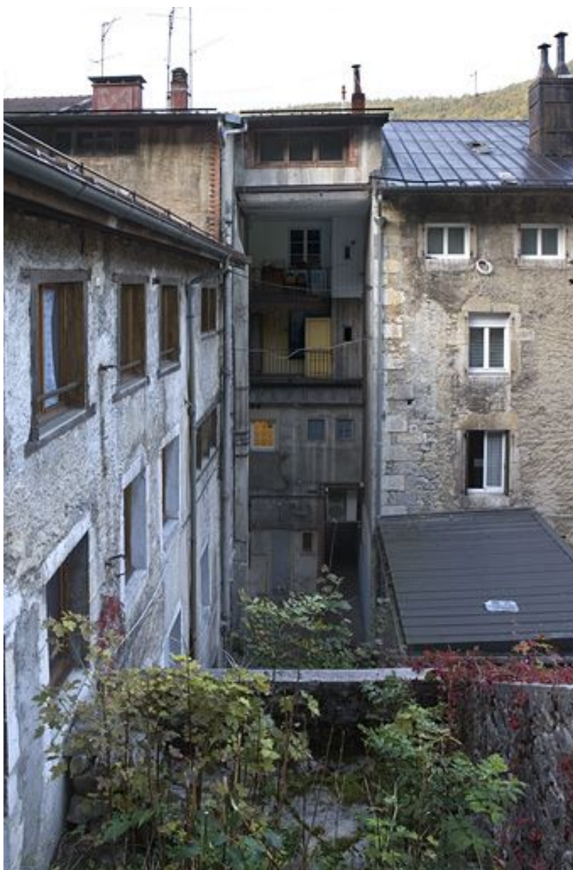
Façade postérieure, depuis le nord-est.
