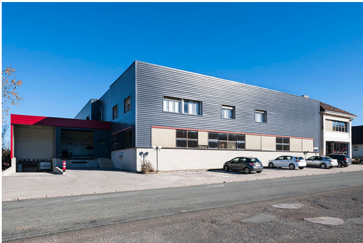
Façade antérieure : ateliers ouest.
