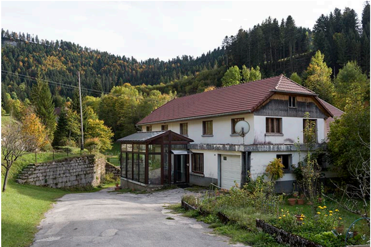
Bassin de retenue et bâtiment, depuis la route au nord.
