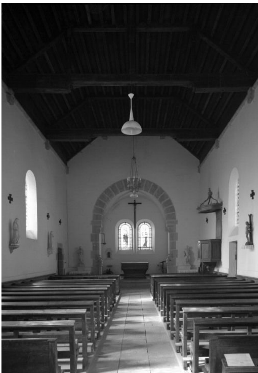
Vue intérieure prise de l'entrée
