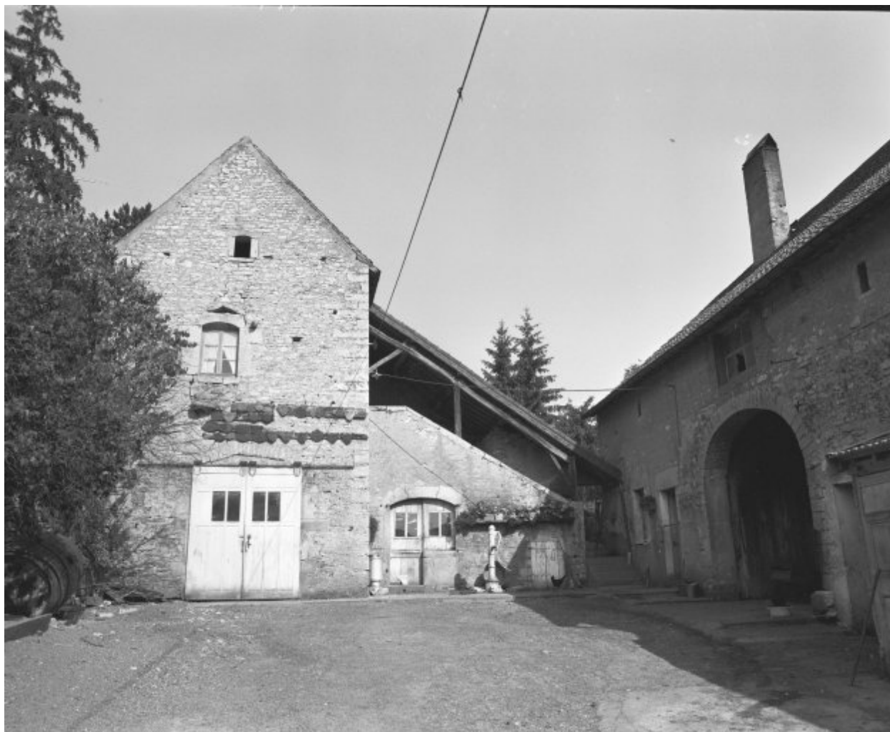
Ensemble des bâtiments : façades sur cour.
