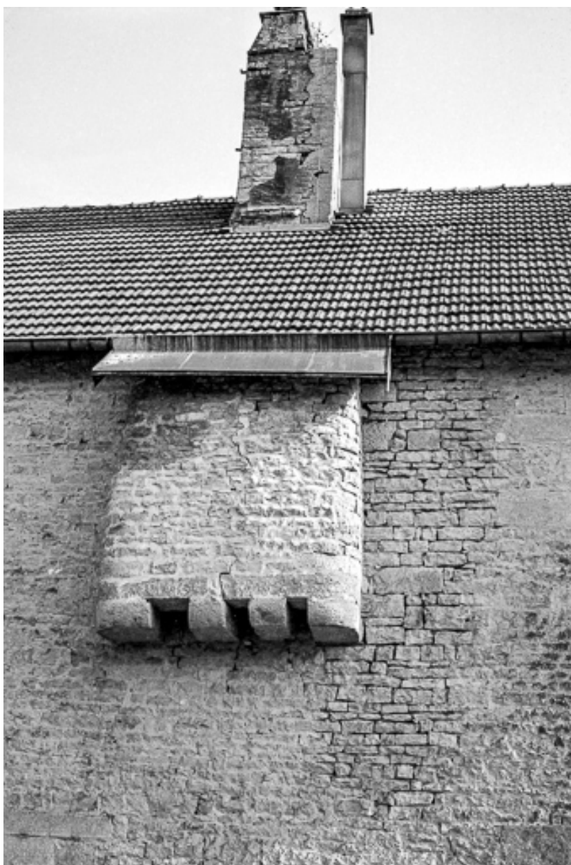
Façade postérieure : cul-du-four extérieur suspendu.
