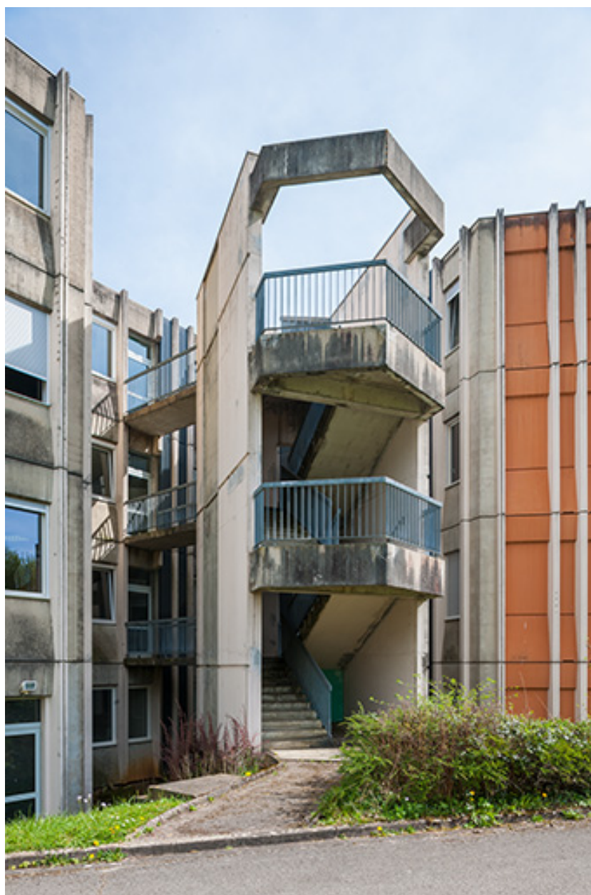
Détail de l'escalier extérieur de l'internat.
