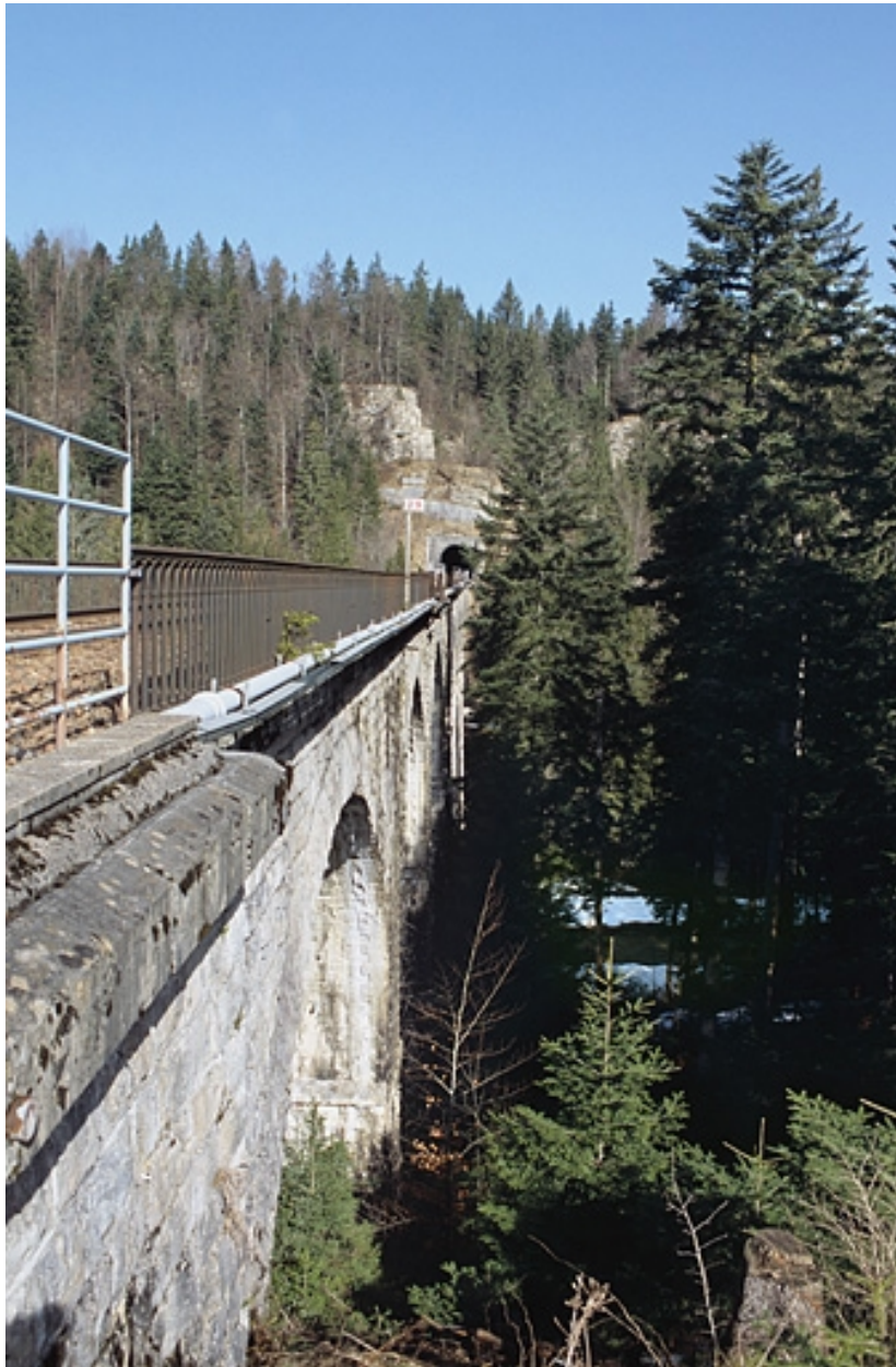
Viaduc : élévation orientale vue en enfilade, depuis le côté La Cluse.
