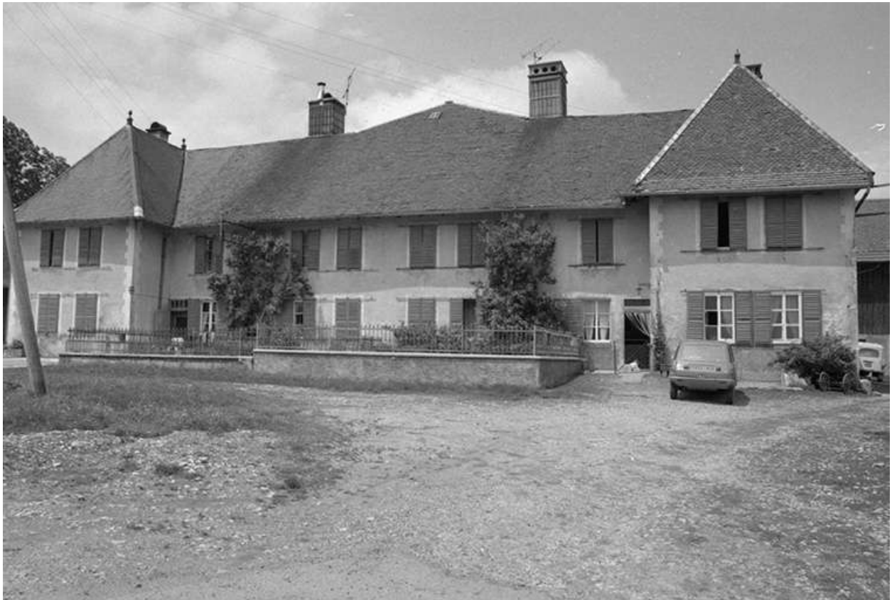
Ferme située 1 Grande Rue : façade antérieure.
