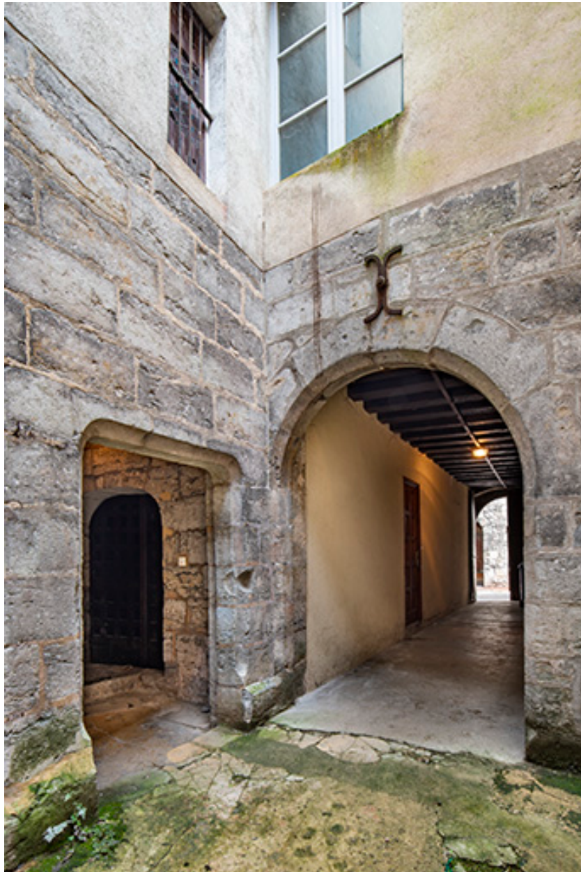
Vue de puis la cour : accès à la tour d'escalier et au couloir d'entrée.
