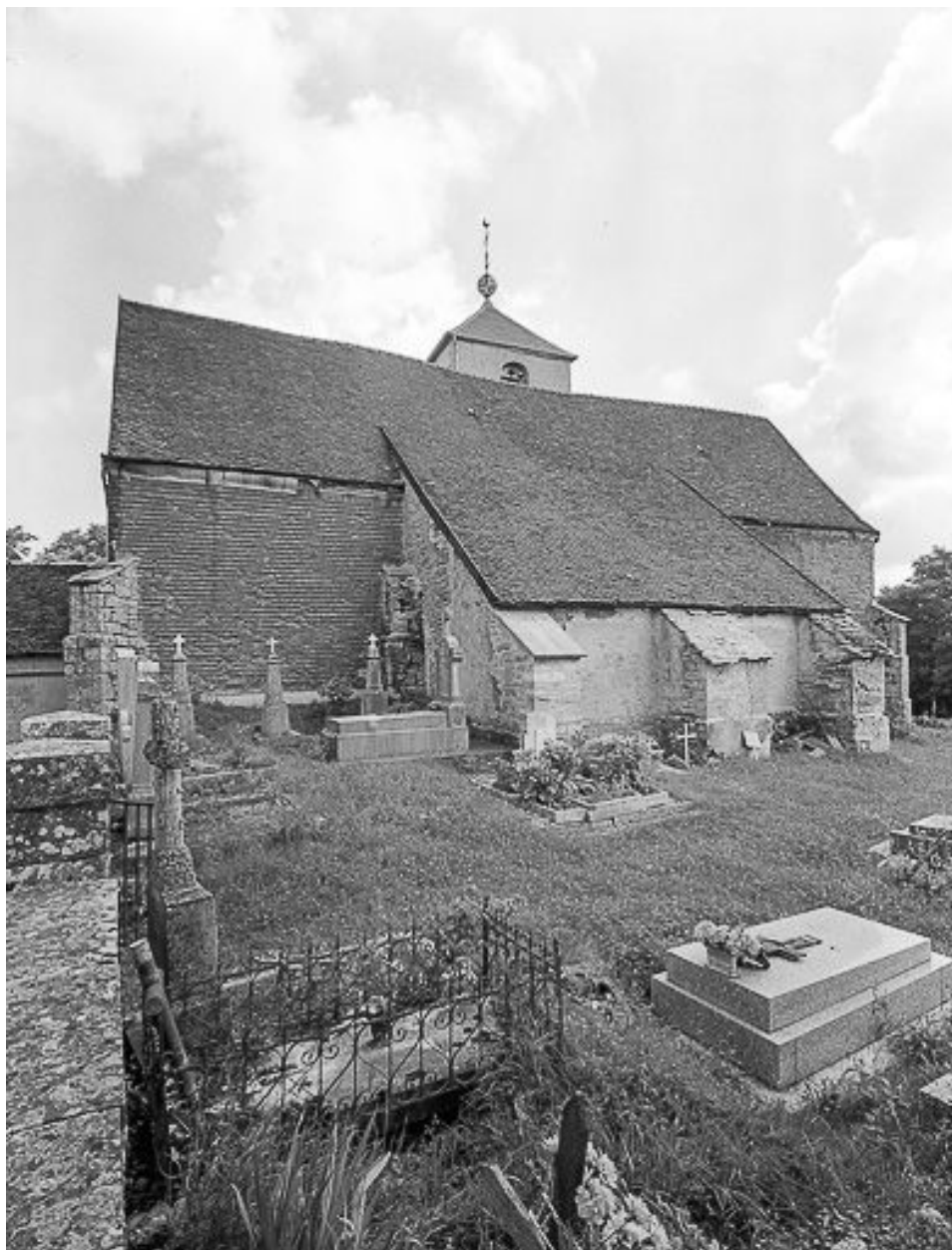
Façade latérale droite vue depuis l'ouest.
