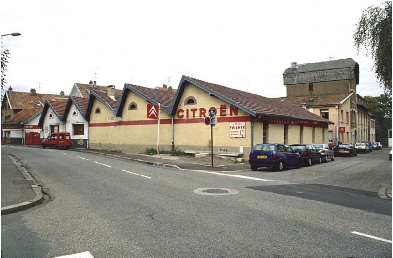
Vue d'ensemble depuis le sud.
