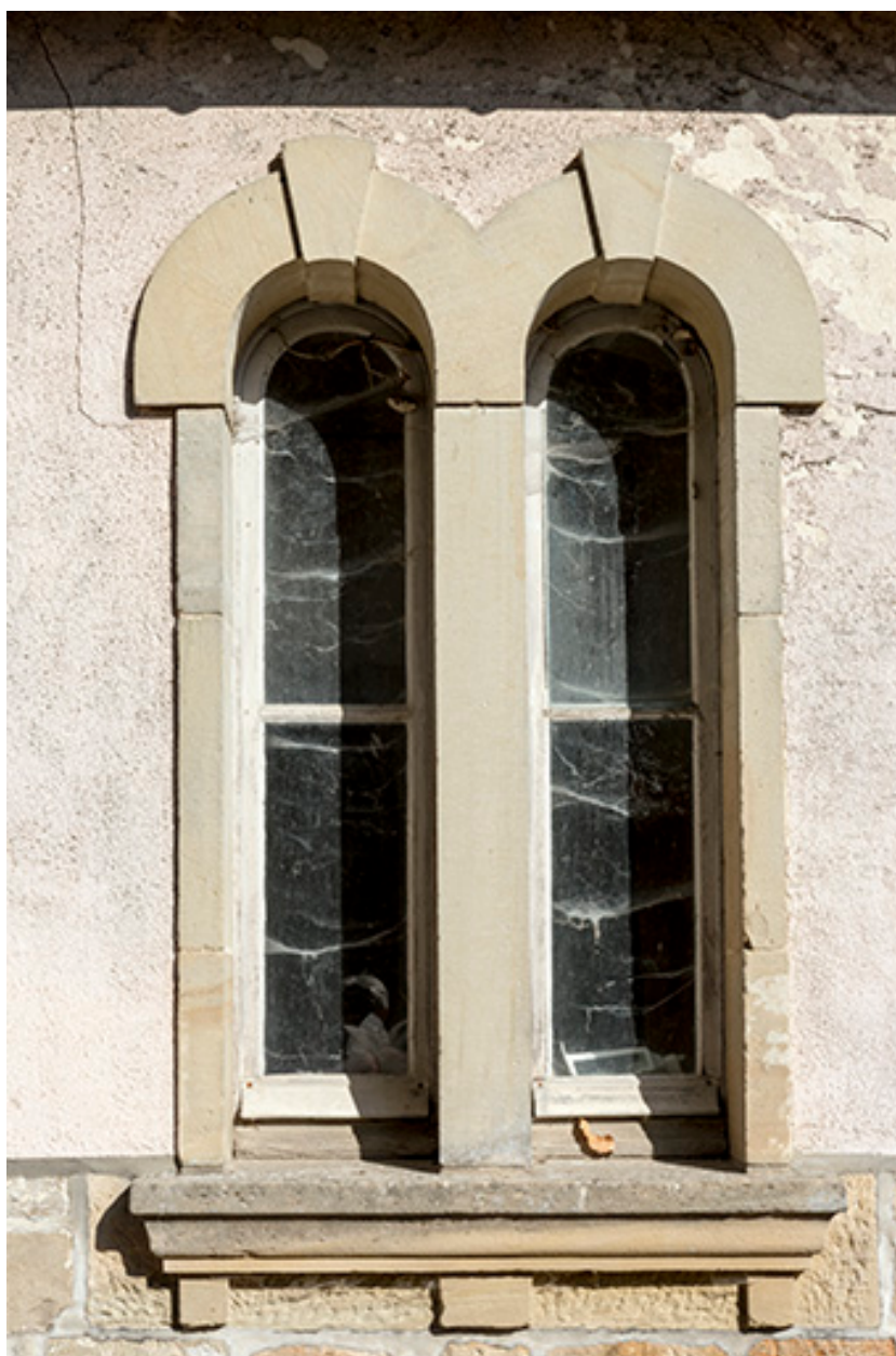
Détail des baies jumelées de l'ancienne dépendance.
