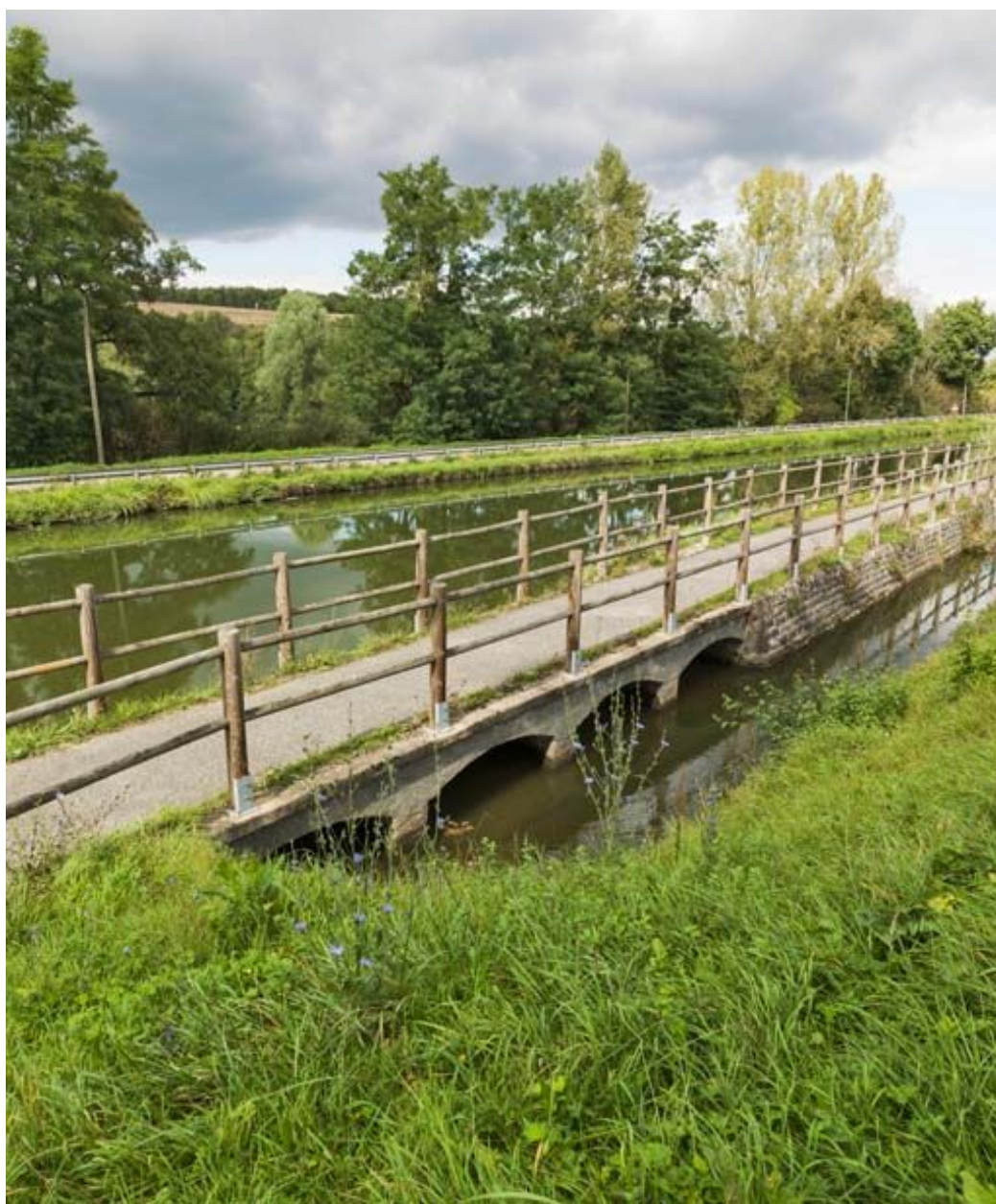
Vue du déversoir.
