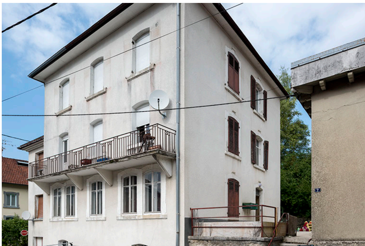
Maison : façades antérieure et latérale droite.
