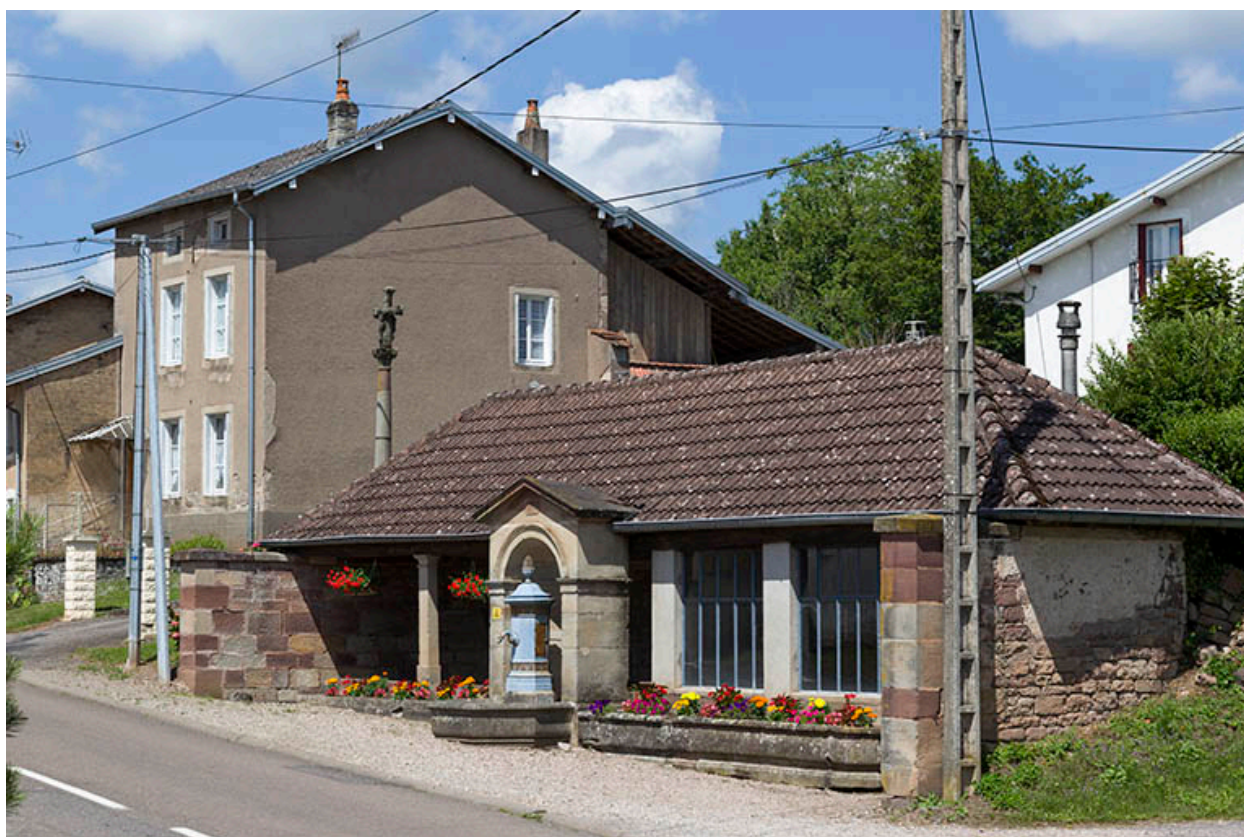
Vue d'ensemble depuis la Grande Rue.
