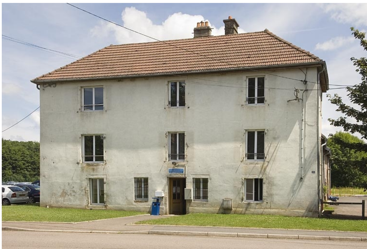
Bâtiment des commis. Façade ouest.
