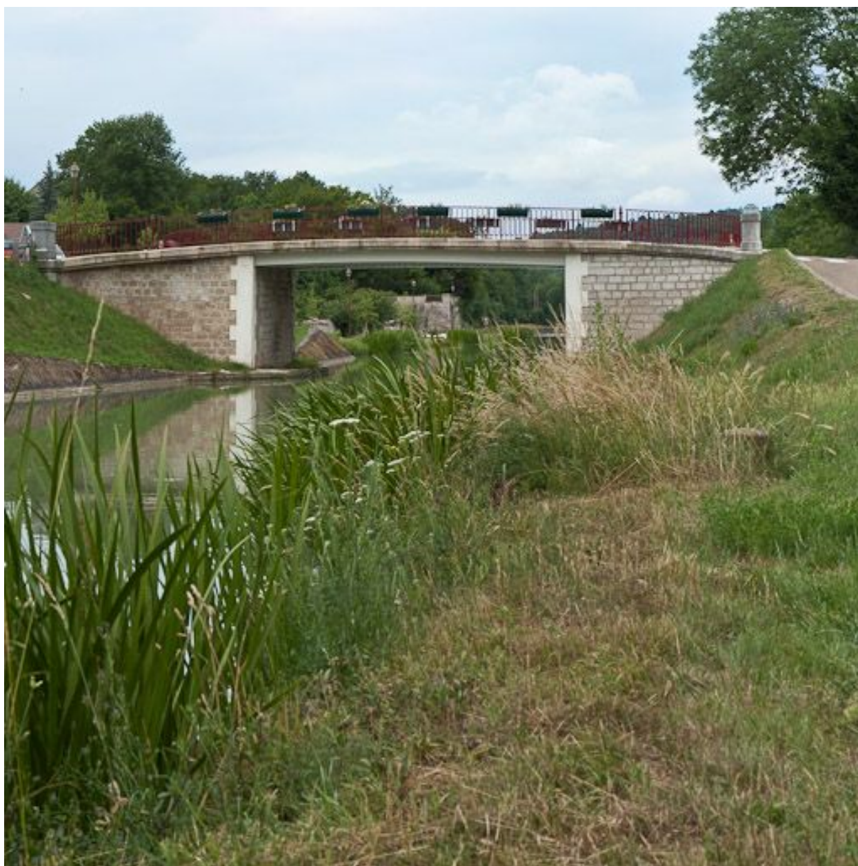
Vue du pont depuis l'aval.
