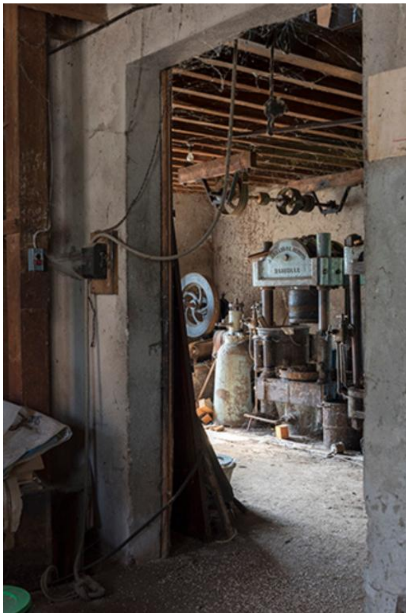
Vue du rez-de-chaussée depuis le magasin
