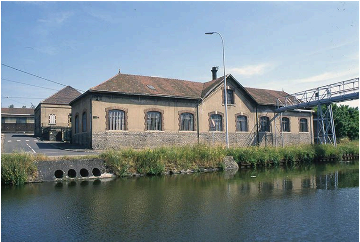
Façade postérieure de l'atelier d'ajustage et de tournage vue depuis les quais.
