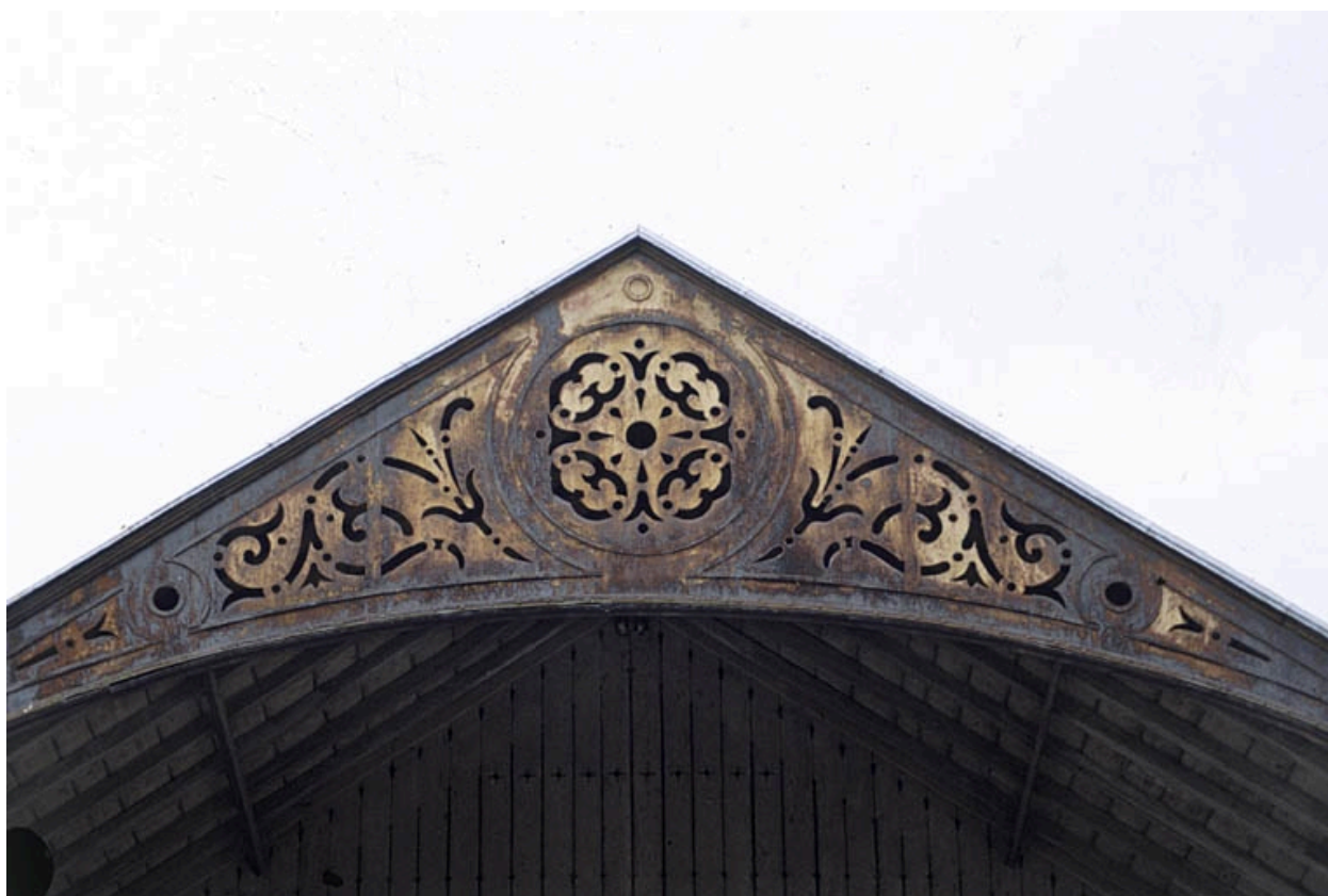
Les écuries : détail du pignon de l'auvent.
