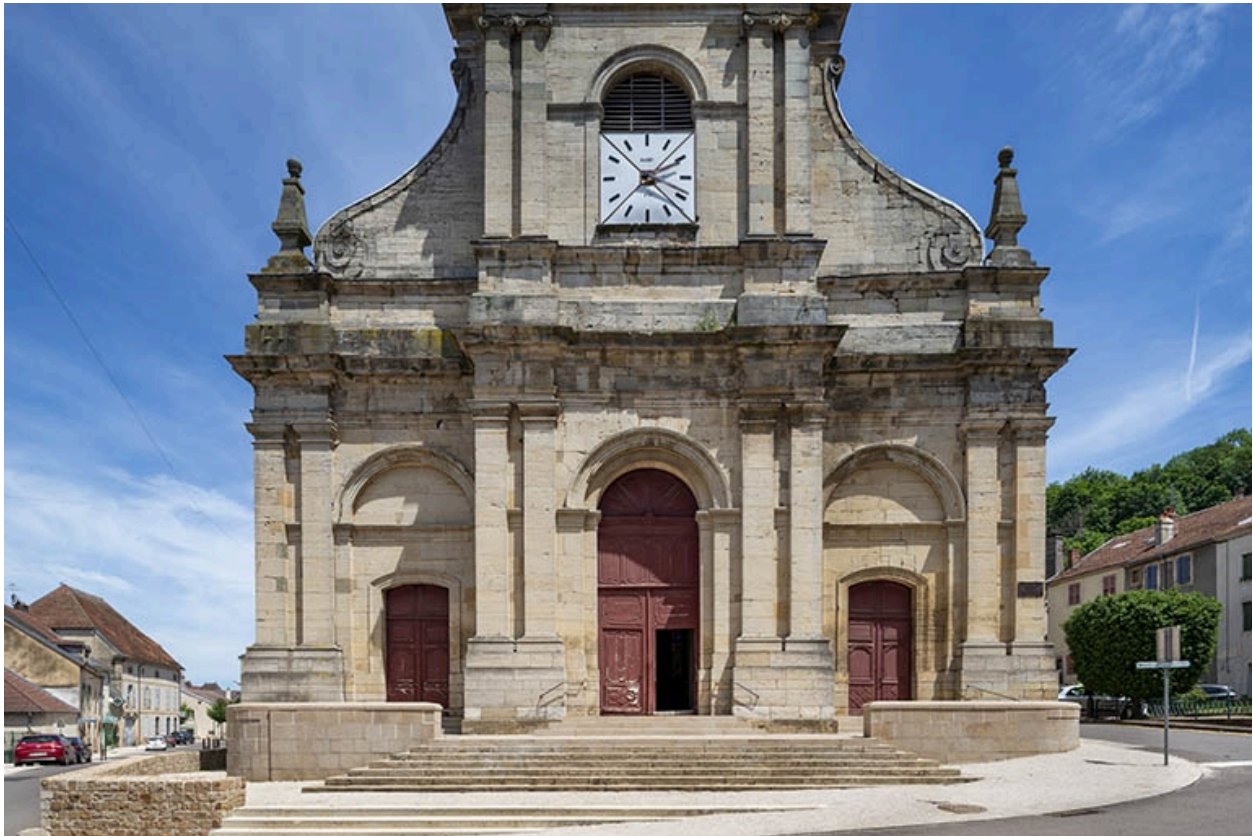
Premier niveau de la façade antérieure.
