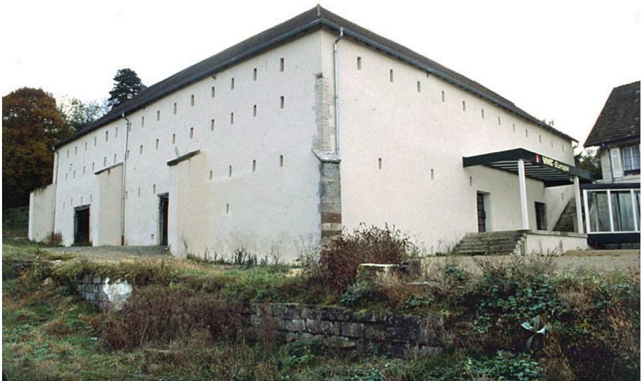
Ancienne halle à charbon depuis le nord-ouest.
