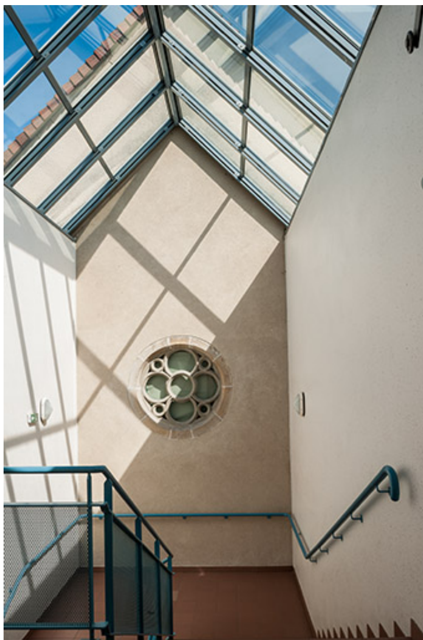
Chapelle : chevet, jonction avec l'extension sud
