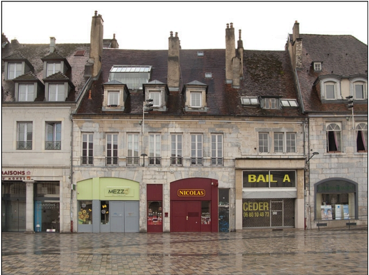
Vue d'ensemble de la façade antérieure, de face.
