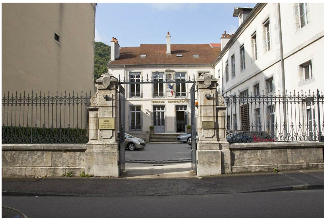
Vue d'ensemble, de face, depuis la rue.
