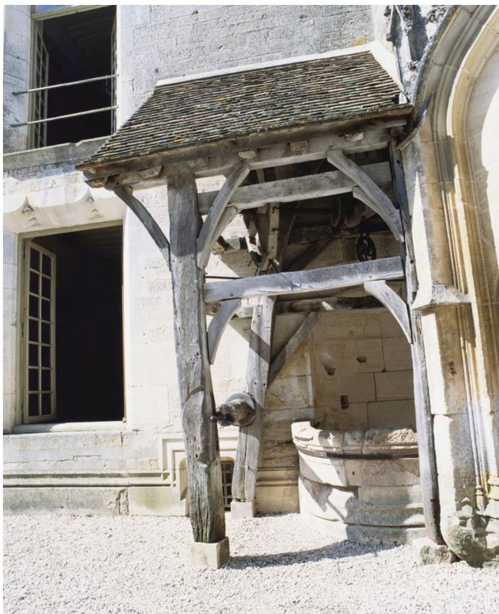
Logis principal, puits sous auvent.
