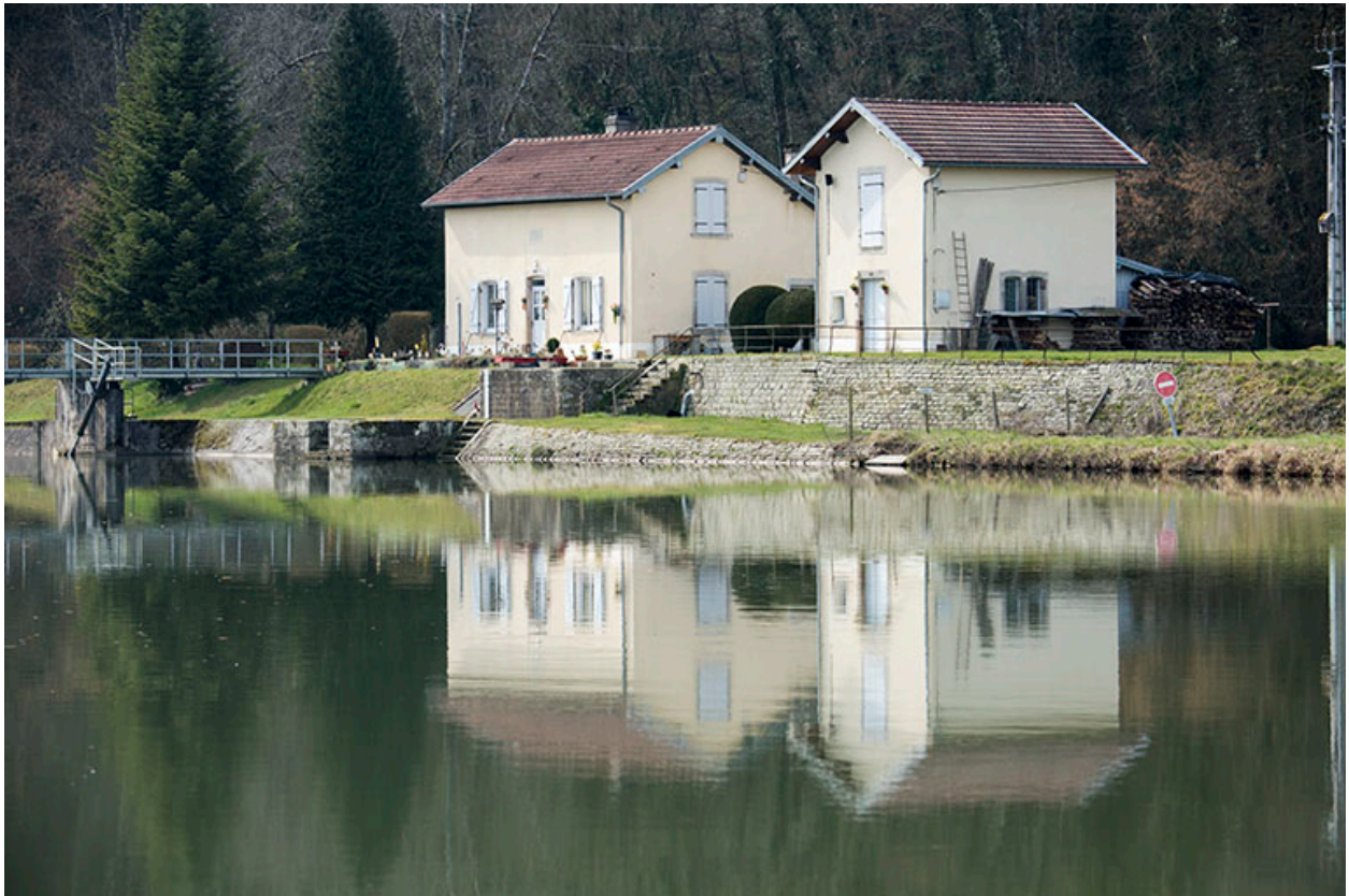
Site du barrage en amont du bief, commune de Ranzevelle.
