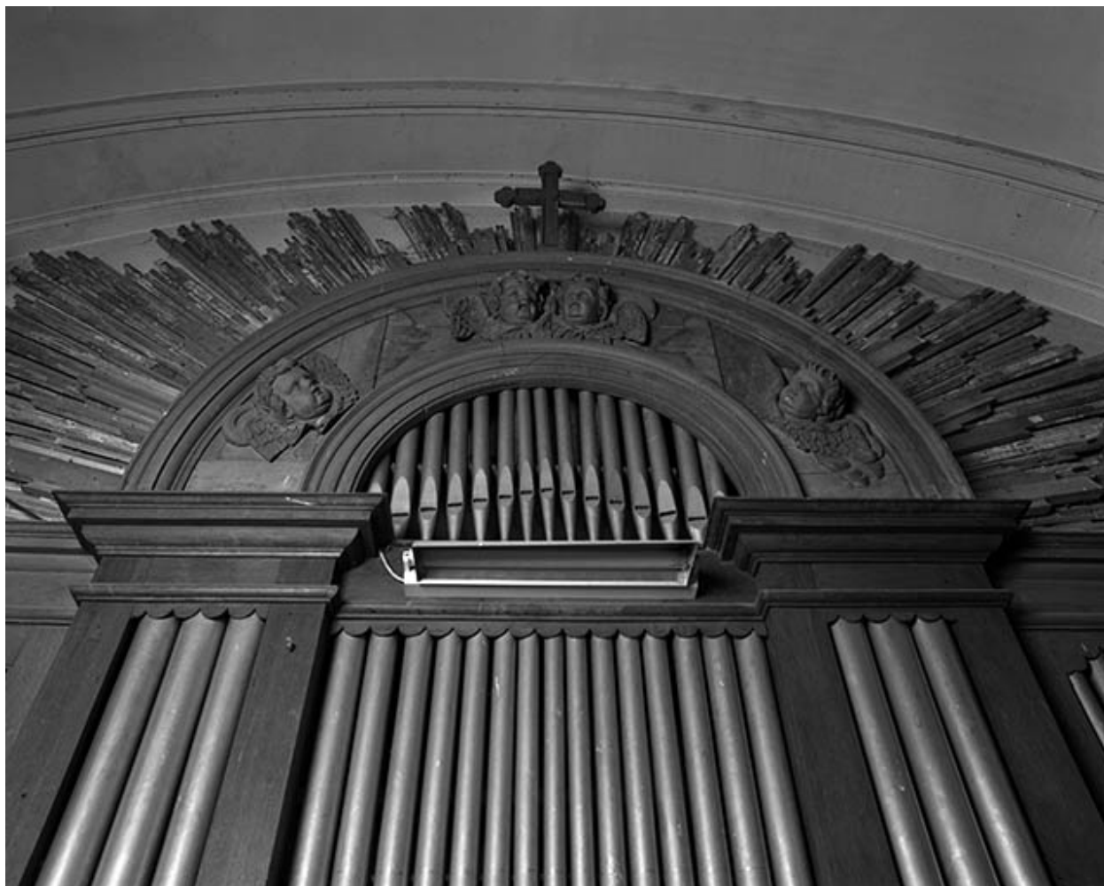
Couronnement vu en contre-plongée.
