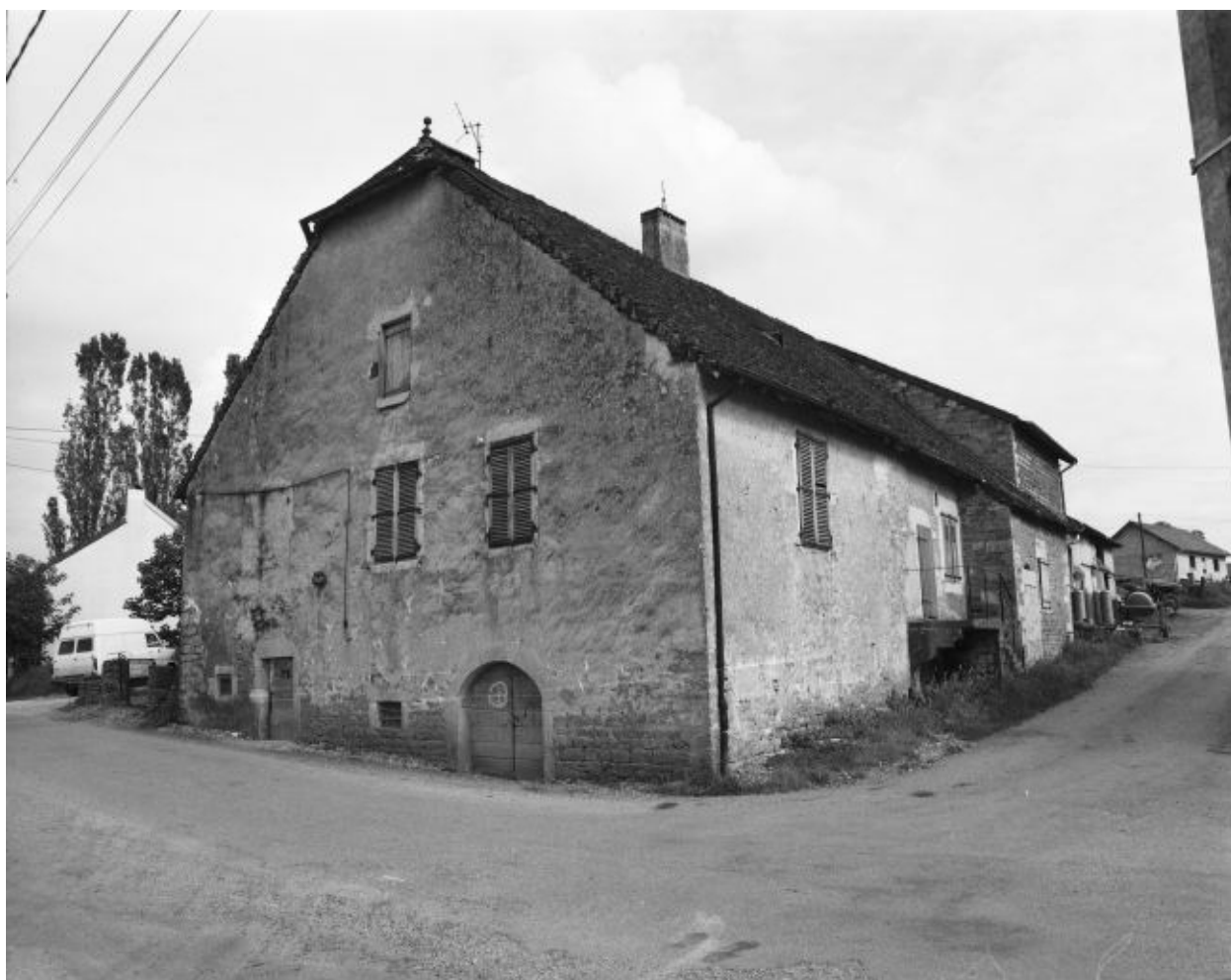
Ferme située rue des Louvarets.
