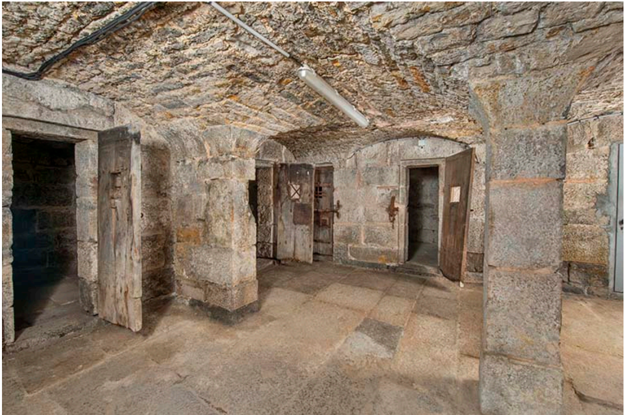
Vue d'ensemble du vestibule ouvrant sur les cellules (portes ouvertes).
