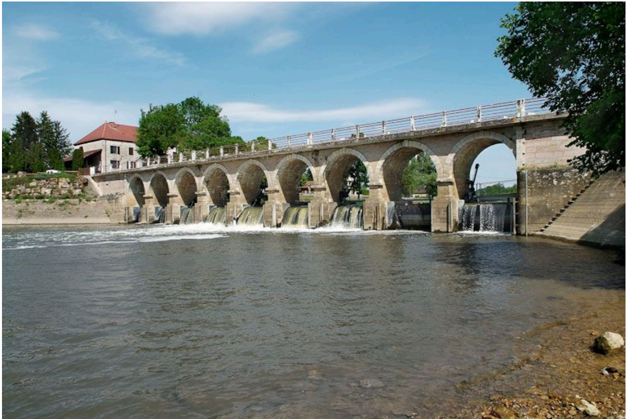
Barrage et pont de La Truchère, vus de la rive gauche de la Seille.
