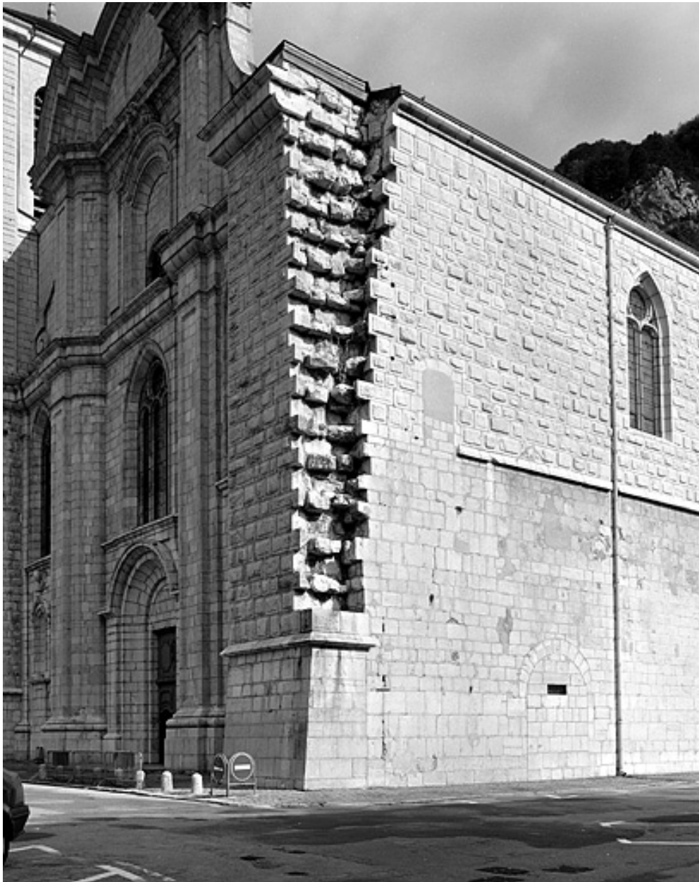
Angle sud de la façade.
