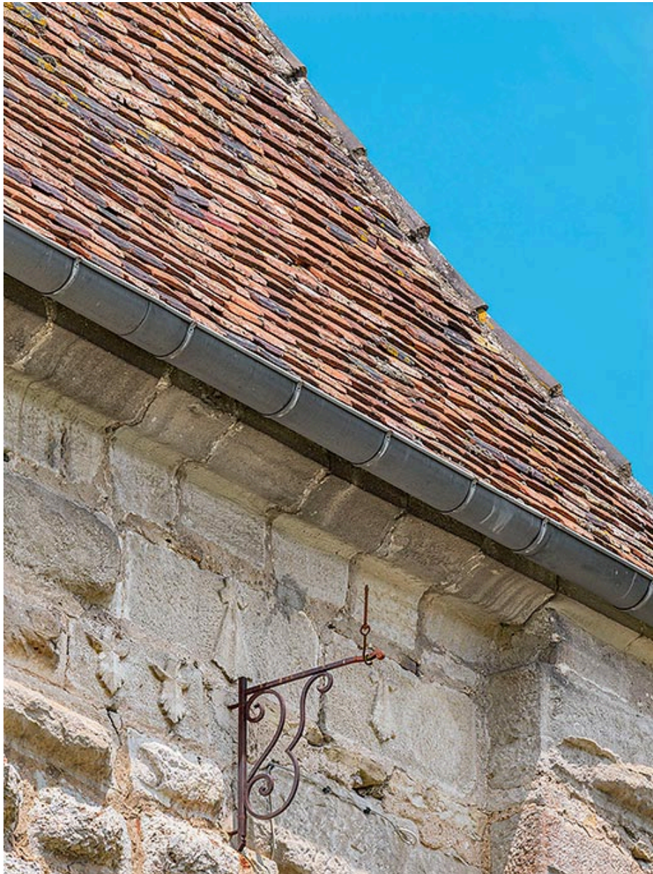
Détail de la corniche et de la couverture en tuile.
