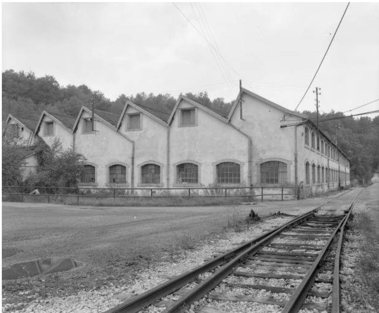
Vue rapprochée de l'atelier des pompes en 1981.
