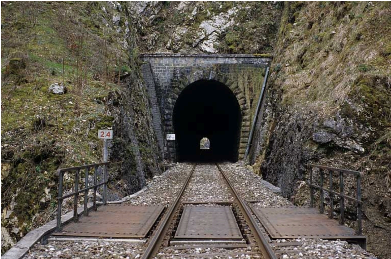
Tunnel : tête côté Andelot-en-Montagne.
