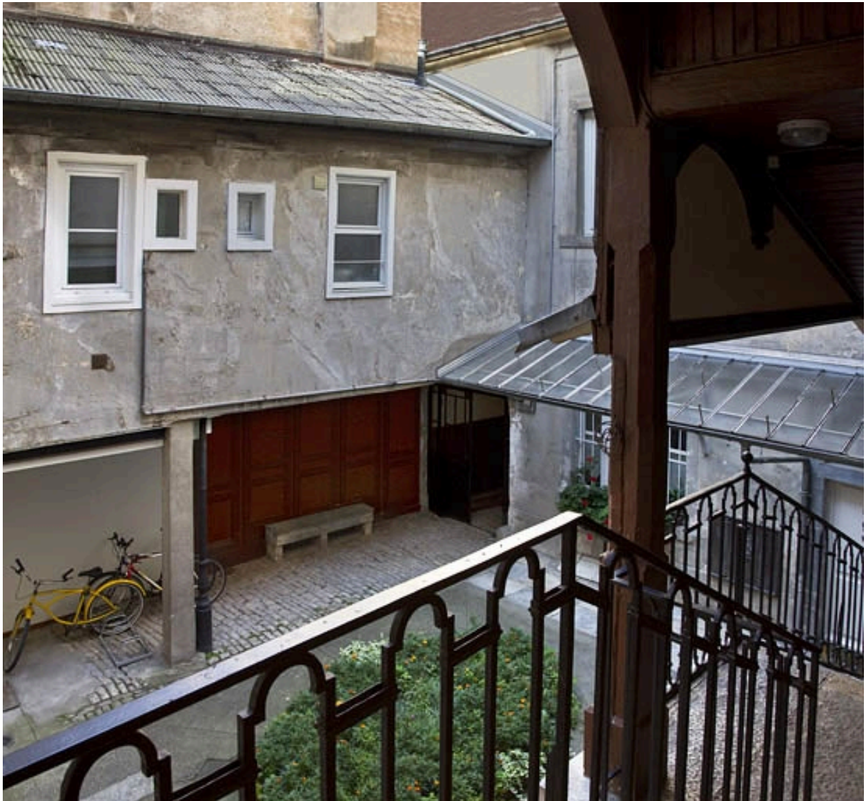
Vue d'ensemble de la cour depuis l'escalier à cage ouverte.
