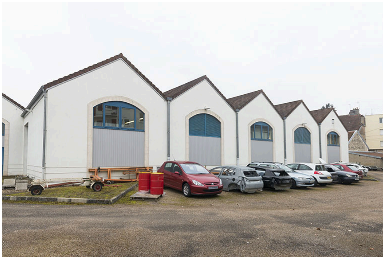
Les pignons nord-ouest des ateliers.
