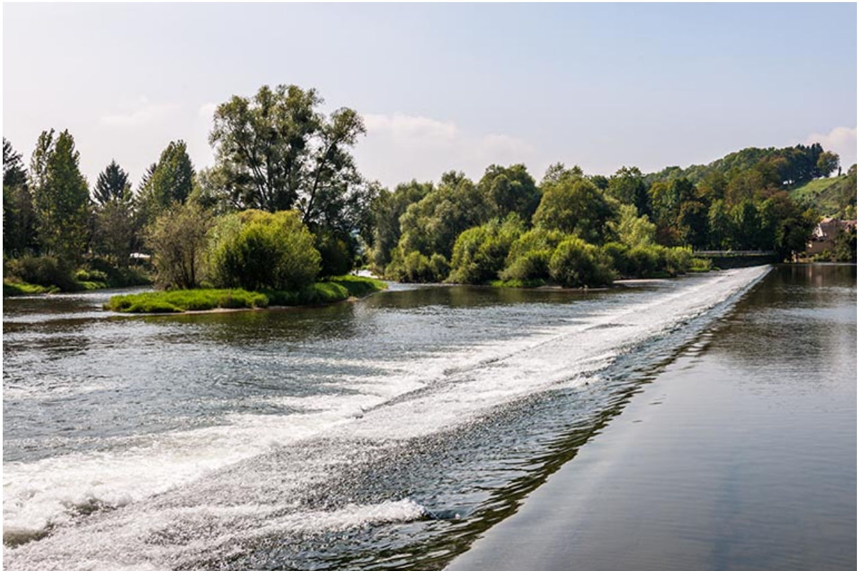
Barrage sur le Doubs.
