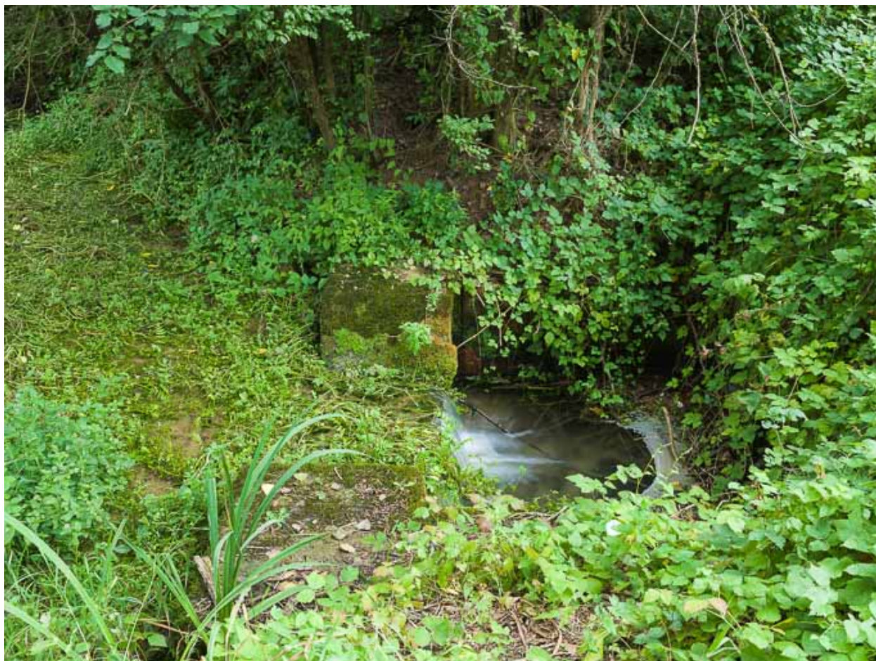
Vue de l'aqueduc dans la végétation.
