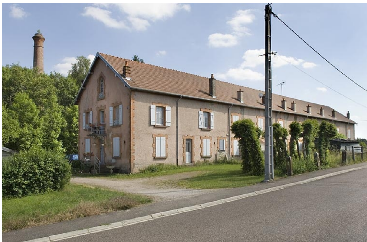
Logement ouvrier dit cité Saint-Anne.
