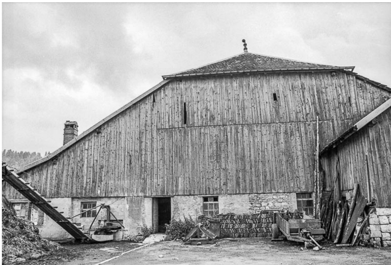
Ferme située 18 Grande Rue : partie agricole.
