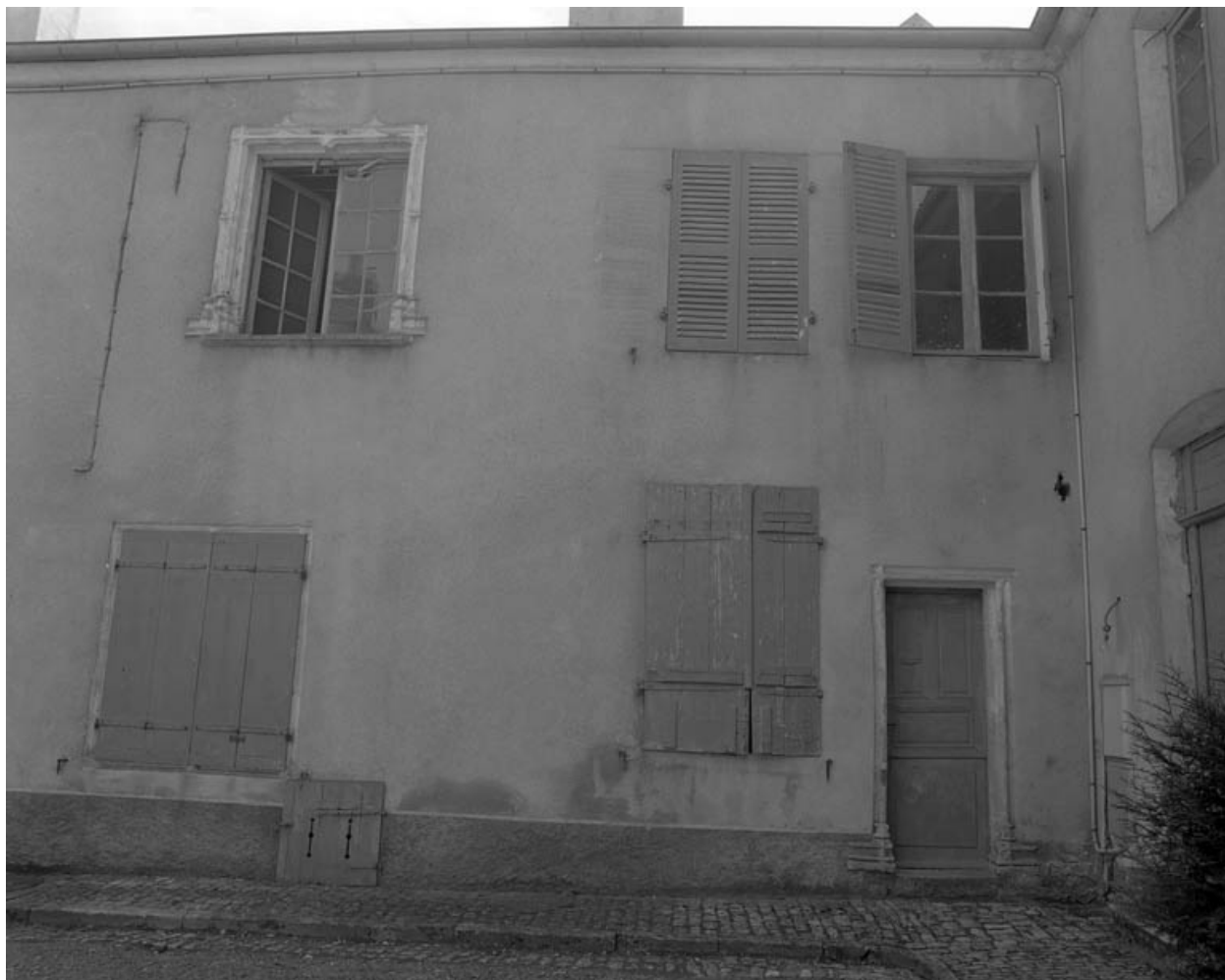
Façade antérieure du logement gauche sur cour.
