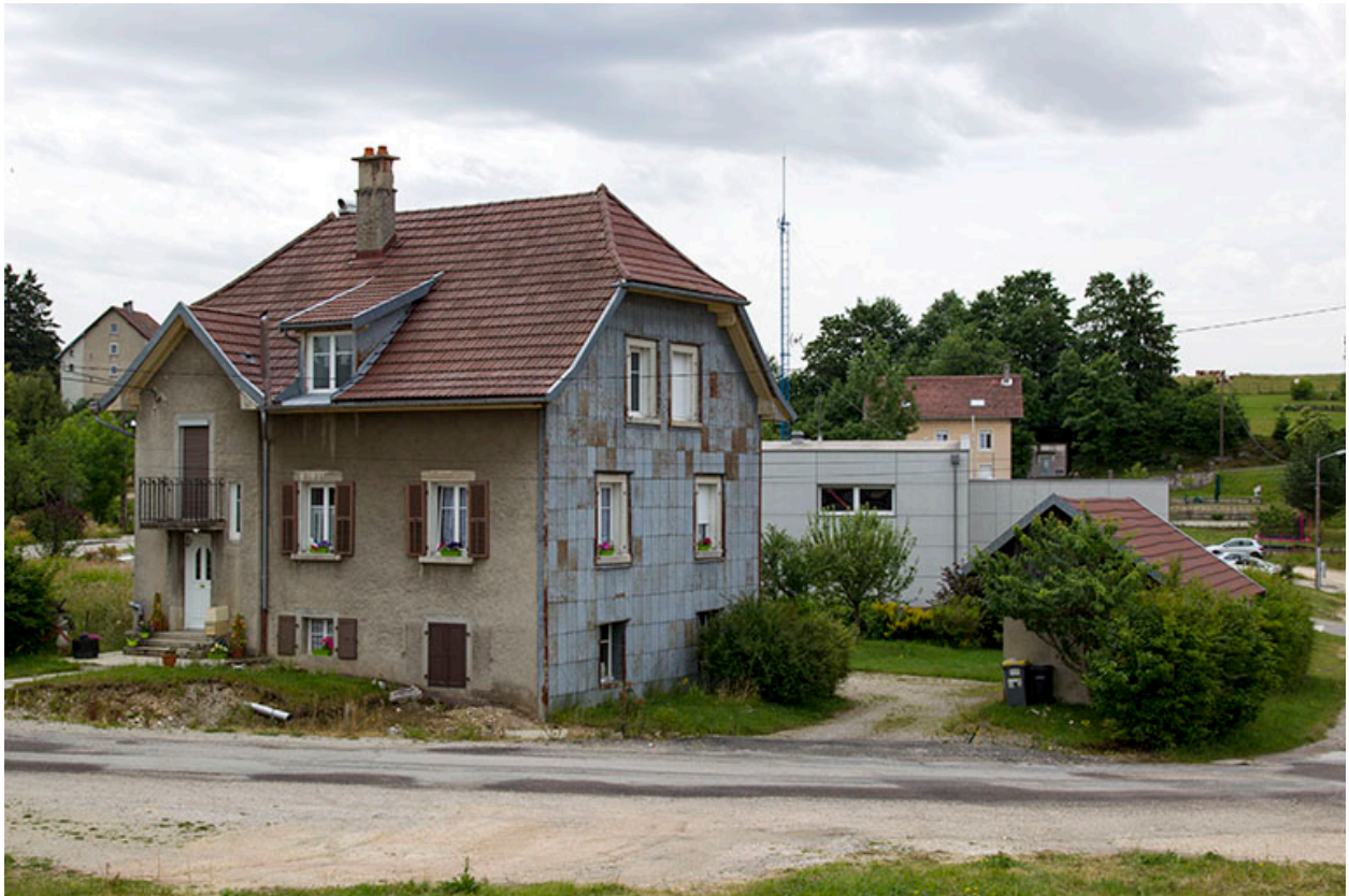
Vue d'ensemble, depuis le nord (façades antérieure et latérale droite).
