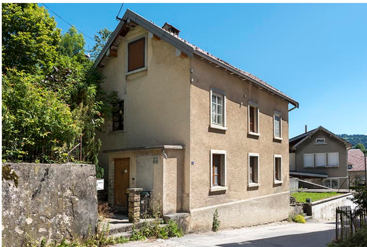
Façades antérieure et latérale gauche.
