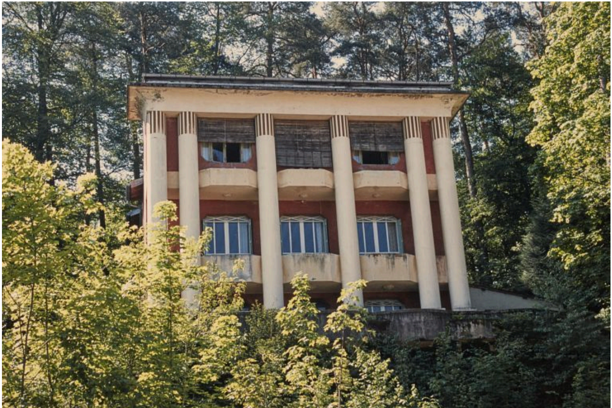
Façade nord, vue de face.
